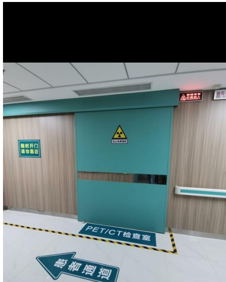
PET/CT 检查室设置门灯连锁、警告标识，电动推拉门带有防夹功能
