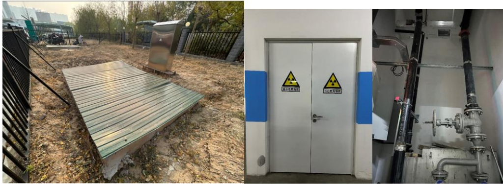
衰变池上方及污泵间
