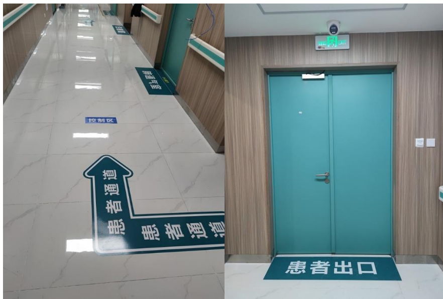
核医学科患者通道入口处设置患者引导标识、控制区标识、电离辐射标识、门禁；患者通道全程设置引导标识；患者通道出口设置引导标识、门禁
