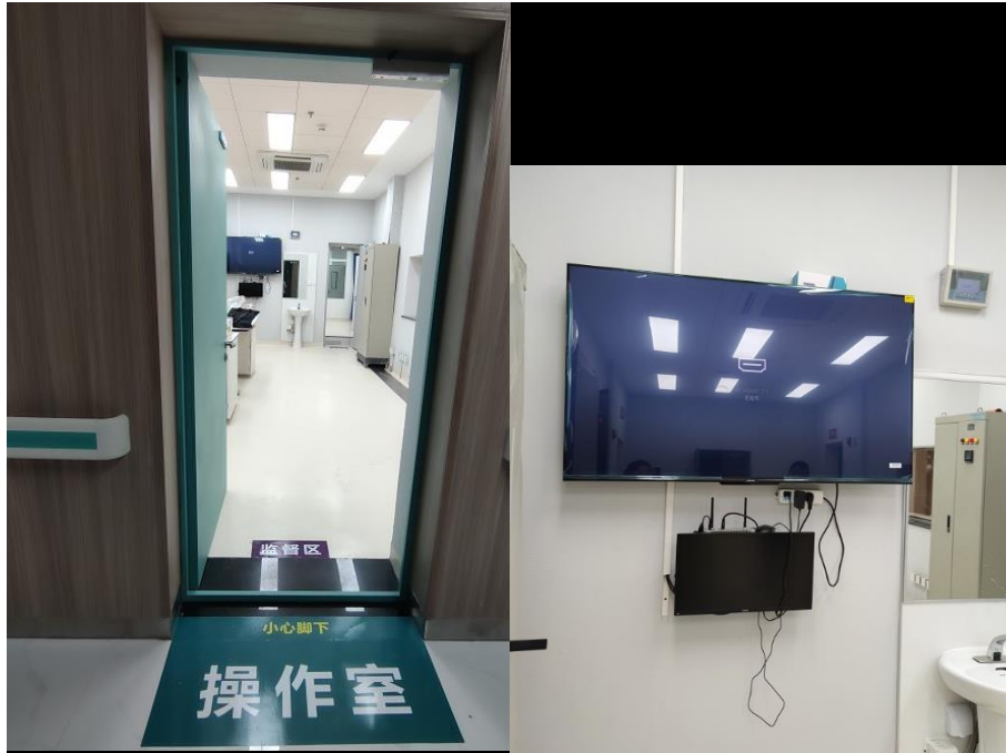
控制室设有地面标识、监控视频系统、门禁
